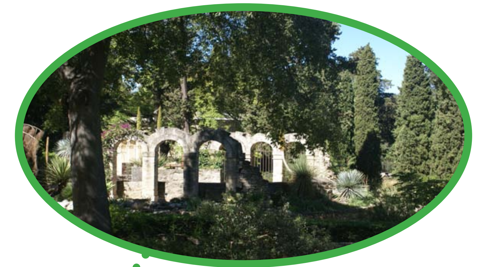
Restauration réalisée de la Noria
