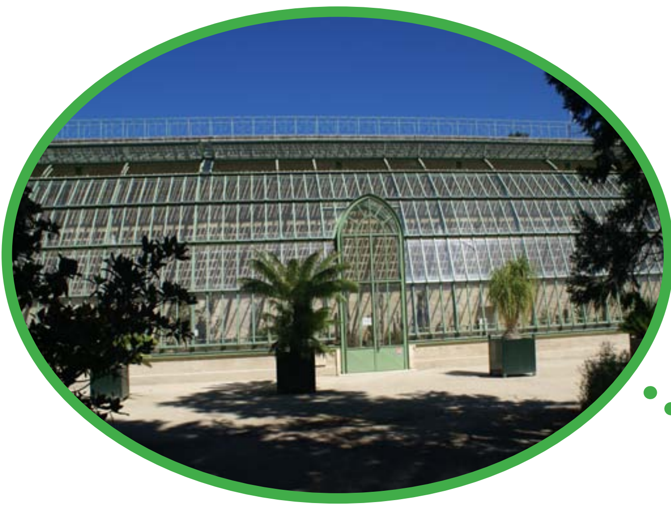
Nouveau plateau technique et restauration de la Serre Martins. Travaux réalisés 2009-2012: 2,3 M€
