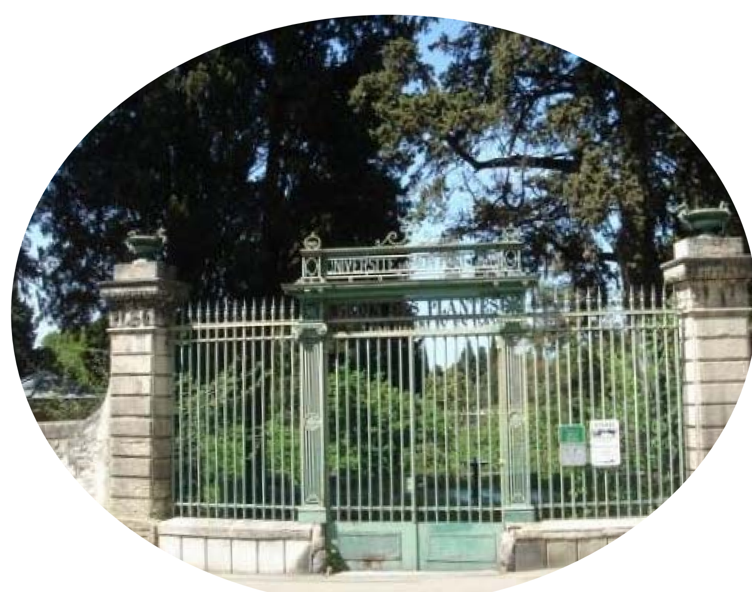
Restauration du mur de clôture et des entrées Sud et Ouest
